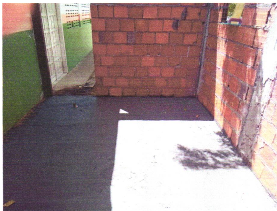
FOTO 11 - PISO EM CONCRETO 20 MPA PREPARO MECÂNICO, ESPESSURA 7CM. AF_09/2020
