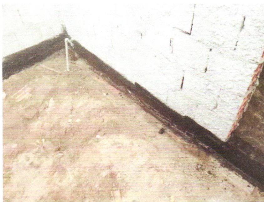
FOTO 11 - PISO EM CONCRETO 20 MPA PREPARO MECÂNICO, ESPESSURA 7CM. AF_09/2020
