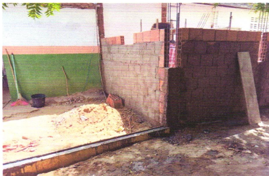
FOTO 05 - Alvenaria bloco cerâmico vedação, 9x19x24cm, e=9cm, com argamassa t5 - 1:2:8 (cimento/cal/areia), junta=1cm - Rev.09
