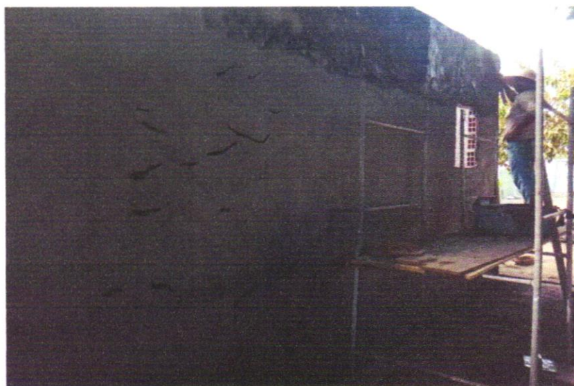
FOTO 07 - CHAPISCO APLICADO EM ALVENARIA (COM PRESENÇA DE VÃOS) E ESTRUTURAS DE CONCRETO DE FACHADA, COM COLHER DE PEDREIRO. ARGAMASSA TRAÇO 1:3 COM PREPARO EM BETONEIRA 400L. AF_10/2022
